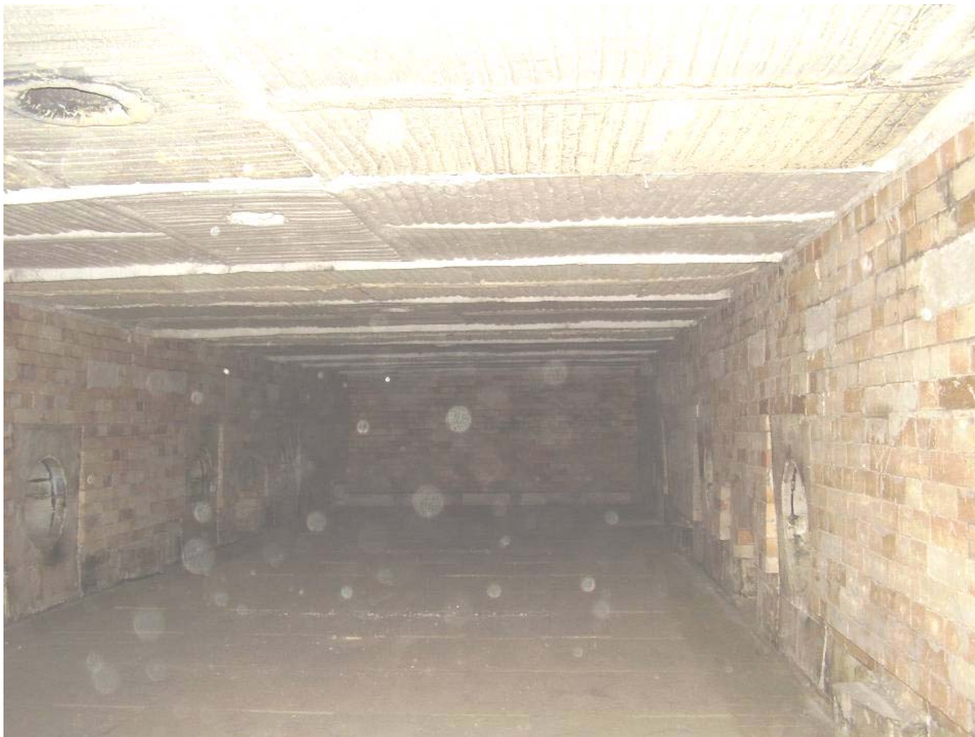
Фото 7. Состояние керамоволокнистой футеровки свода через 5 лет работы методической печи при температуре 1300 °С.
