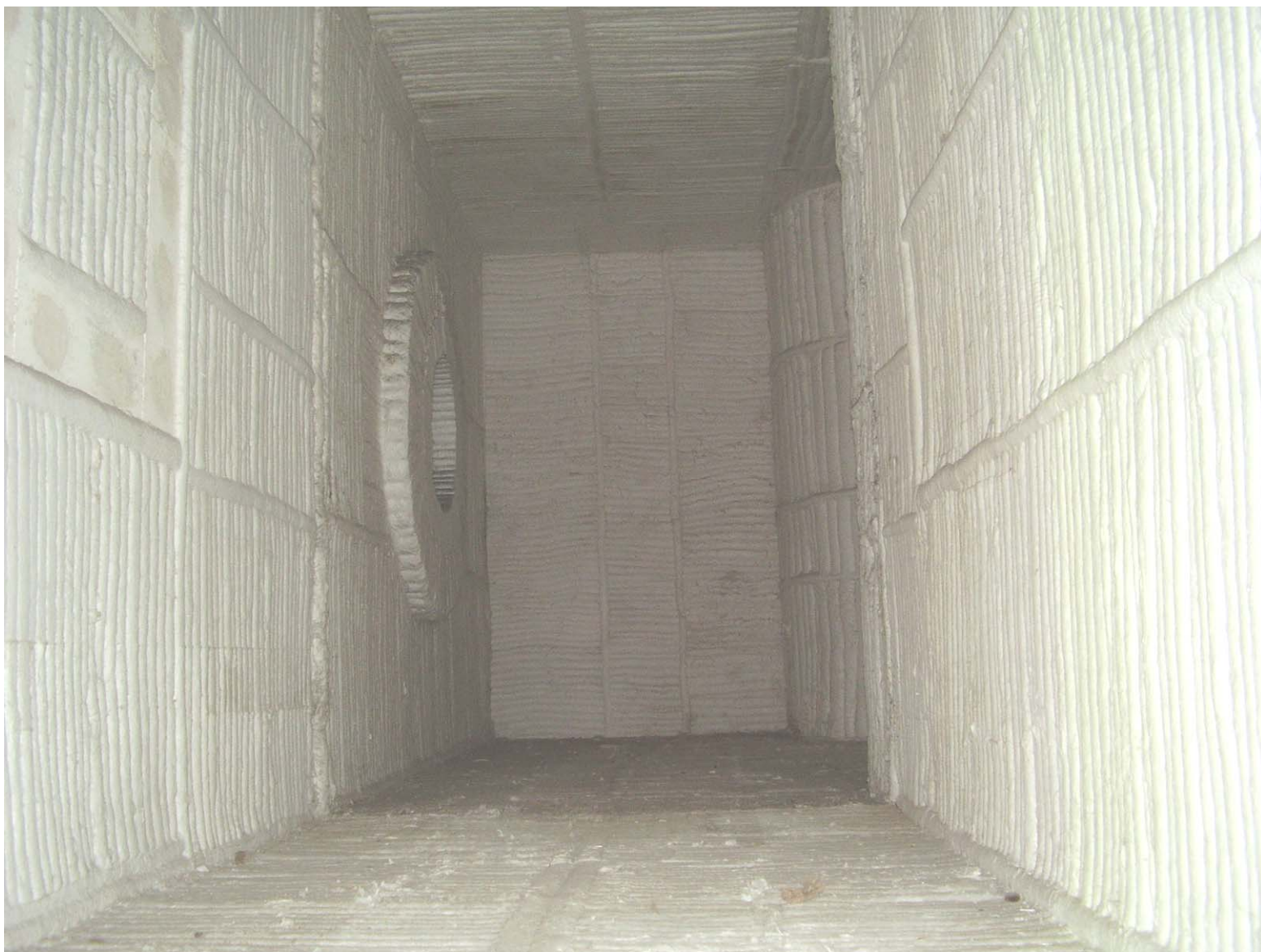
Фото 5. Футеровка дымохода методической печи.
