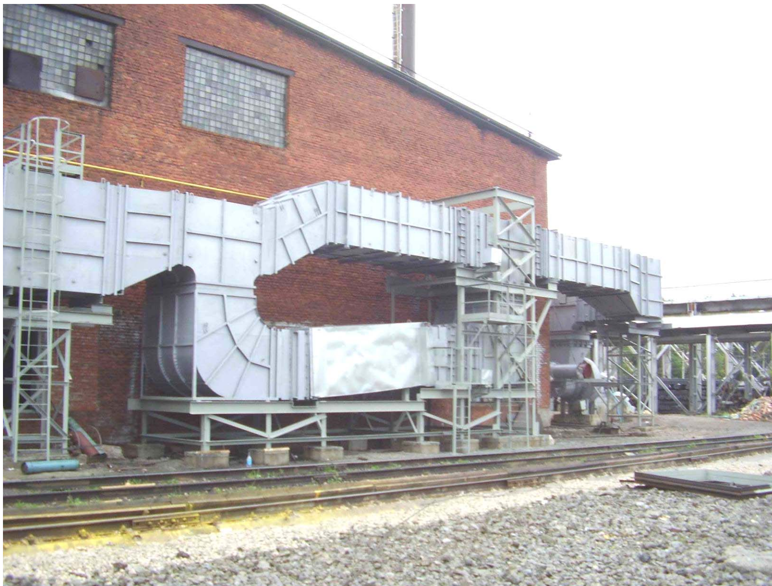
Фото 4. Дымовой тракт методической печи с водяным экономайзером утилизации тепла дымовых газов для целей отопления и горячего водоснабжения.
