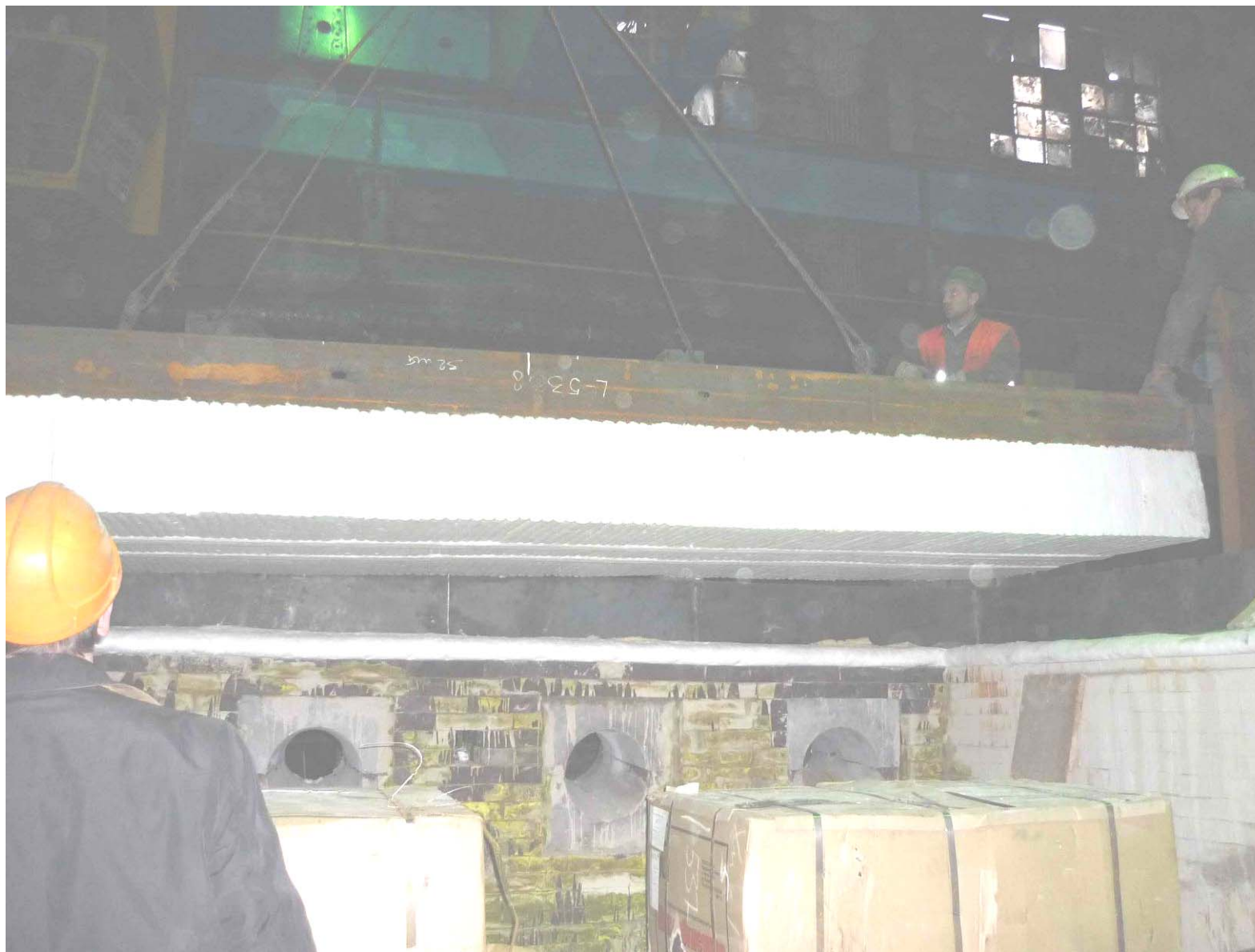
Фото 1. Установка сводовой панели методической печи.
