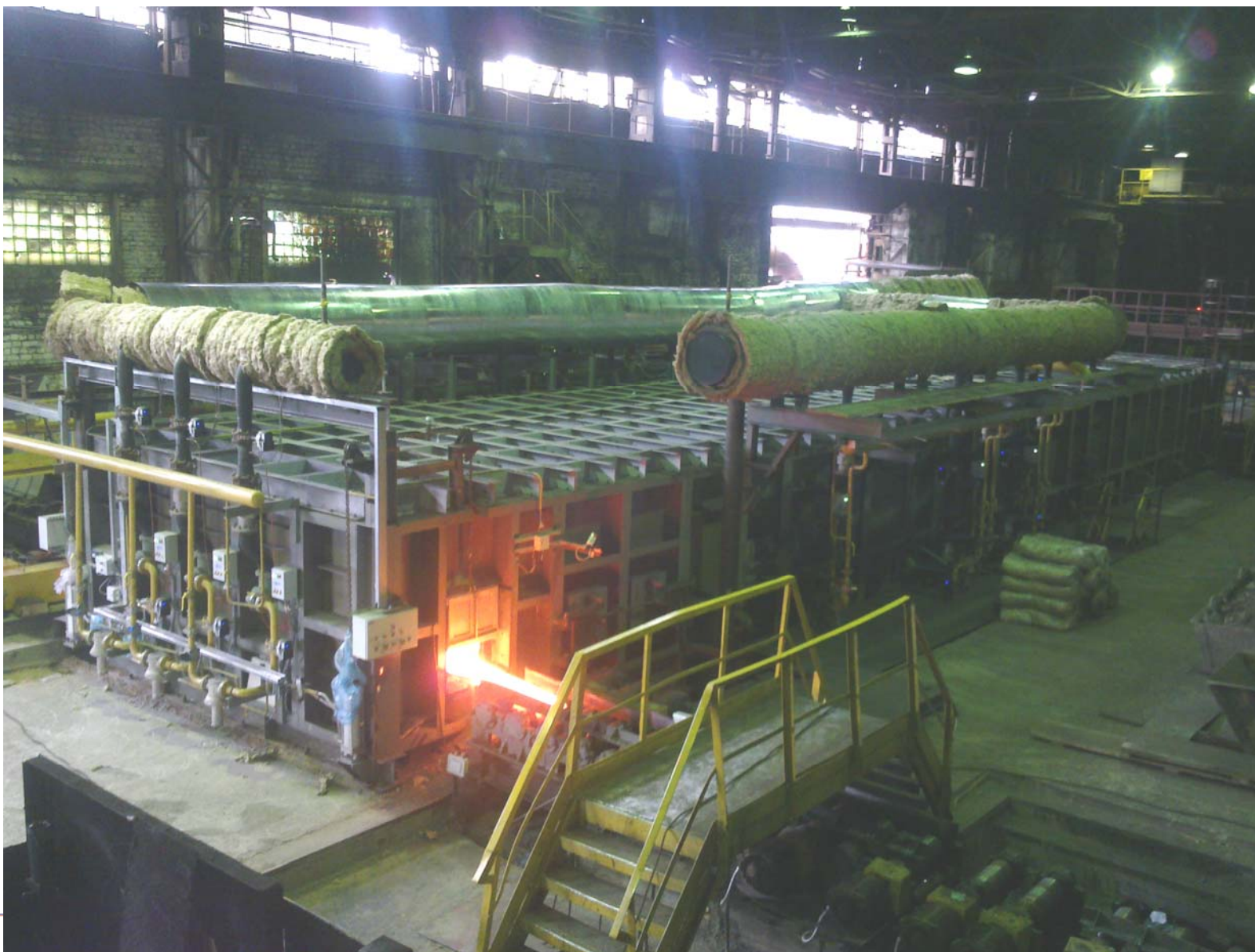
Фото 8. Методическая печь с панельным сводом АНХ-Инжиниринг (воздухопроводы находятся в процессе изоляции)
